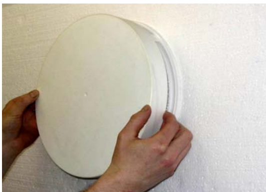
Bild 14: Aufsetzen der Innenblende
