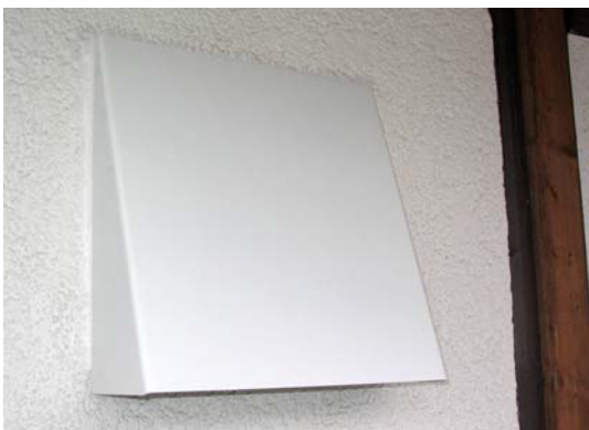
Bild 10: Außenhaube abgedichtet
