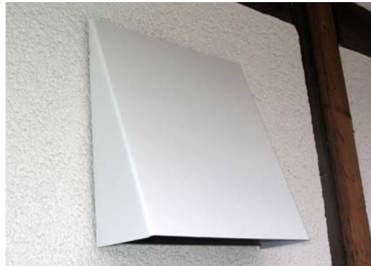
Bild 8: Außenhaube eingesetzt
