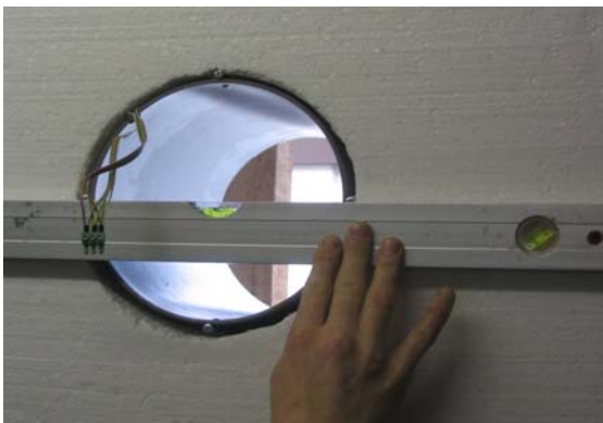
Bild 3: Waagerechter Einbau
