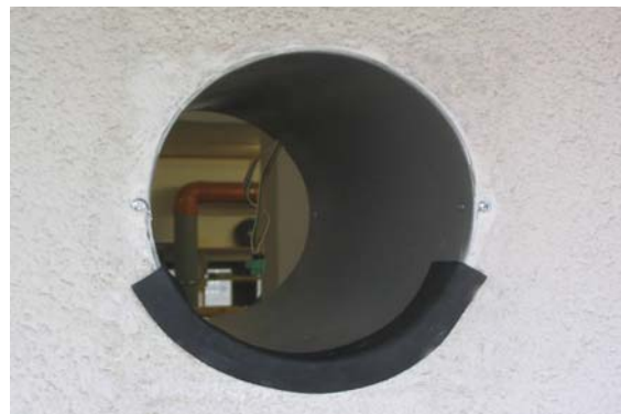
Bild 4: Befestigungselemente waagrecht!
