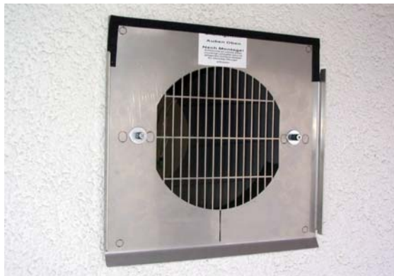
Bild 7: Außenplatte montiert
